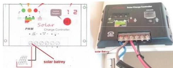
Gambar 15 Instalasi kabel solar cell pada SCC
