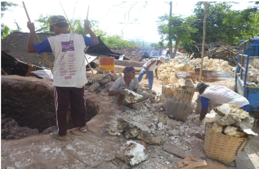
Gambar 10. Para kuli atau pekerja sedang memilah-milah batu kapur tau batu gamping matang yang besar-besar untuk diangkut dan dijual.
