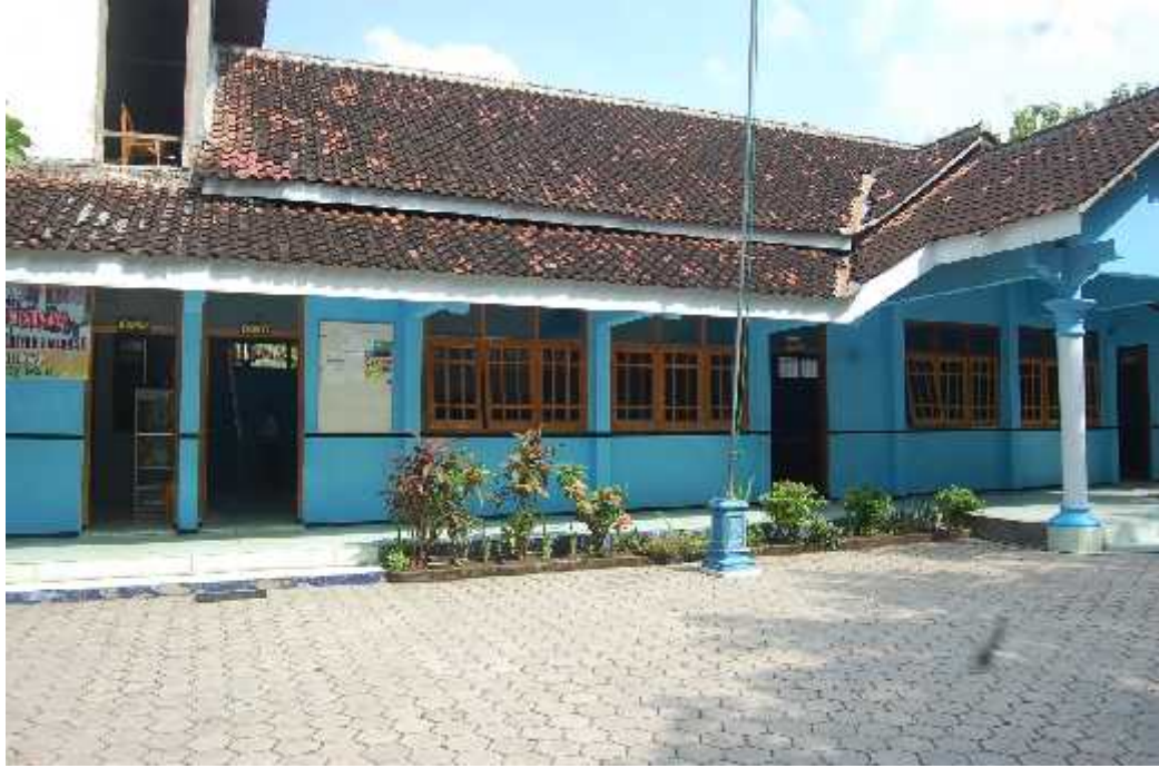
Foto Bangunan Sekolah SMP Muhammadiyah 7 Bajang Mlarak
