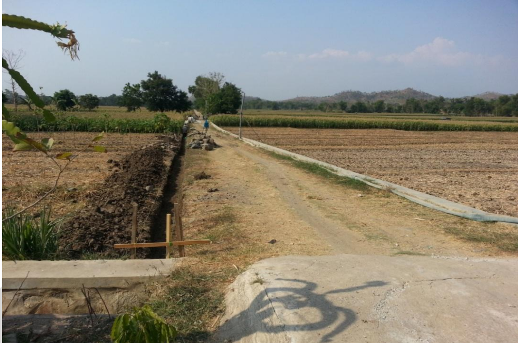
Gambar 8 Pembangunan Talut Pengaman Jalan di Jalan Kinanti
