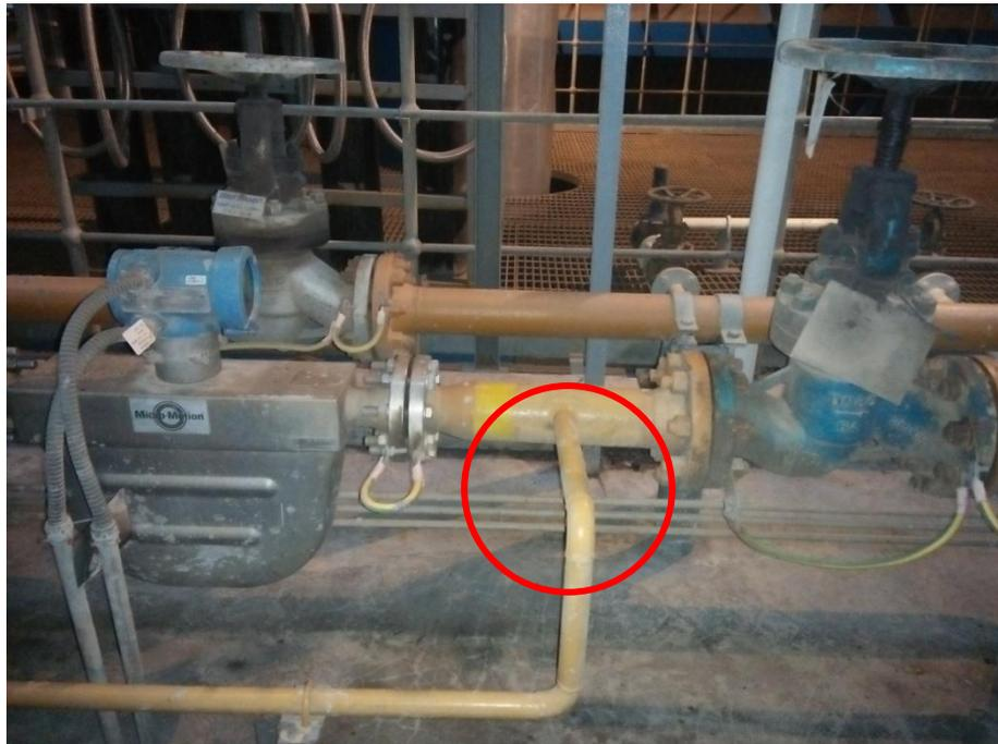
Gambar : 2.11 Percabangan pipa *tiny oil* dari *line* utama HSD
