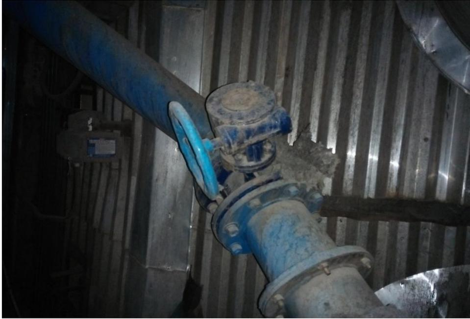
Gambar : 2.12 *Manual valve supply* udara pembakaran *tiny oil*
