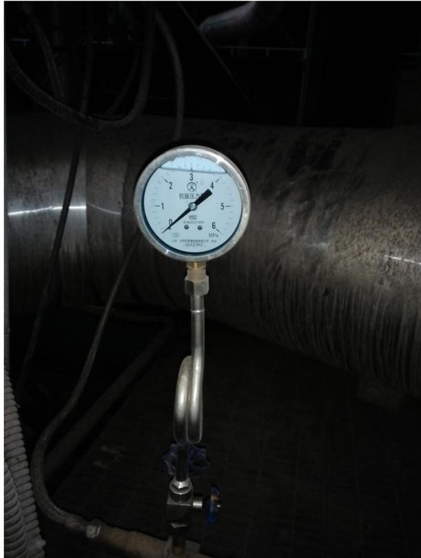
Gambar : 2.18 *Pressure gauge tiny oil* saat keadaan beroperasi.
