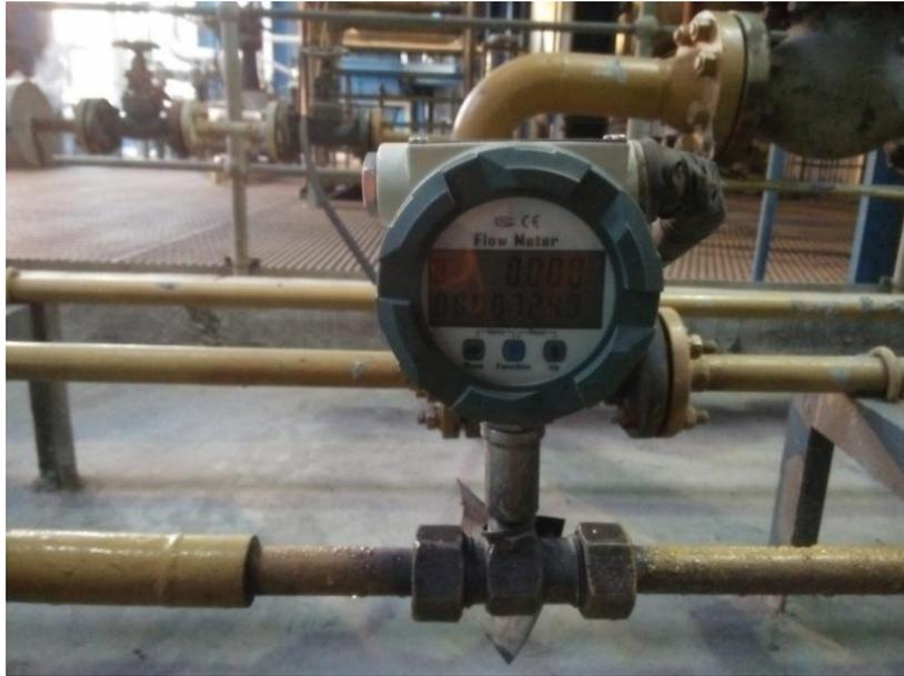
Gambar : 2.6 *Counter flow* indikator
