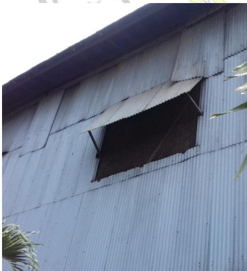
Adanya ventilasi udara pada tempat kerja
