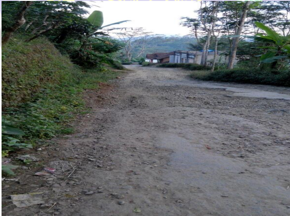
1.2 Kondisi jalan utama desa Mujing rusak parah
