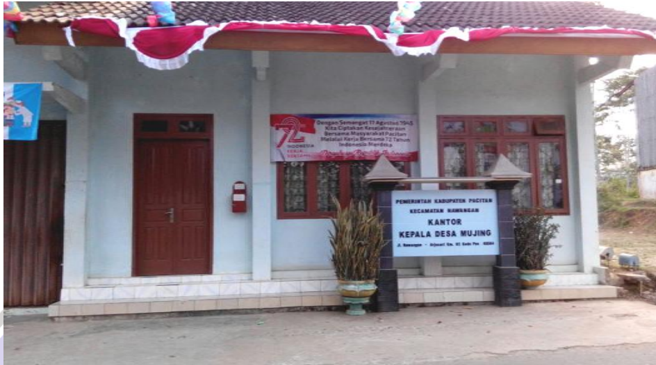
1.1 Gedung balai desa Mujing
