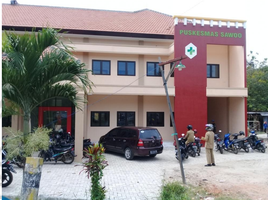
Puskesmas Sawoo tampak dari depan setelah di rehab
