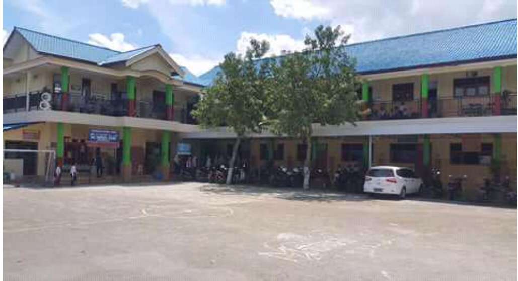
Foto gedung sekolah MI Darul Fikri
