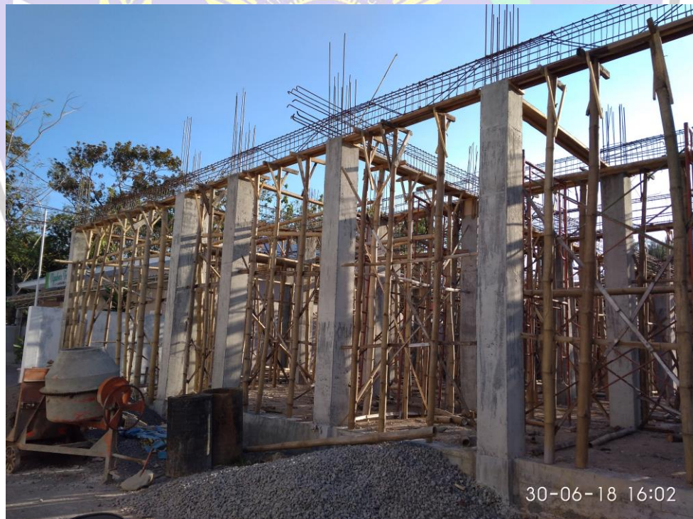
Proses Pembangunan Home Stay (sumber: dokumentasi pribadi)
