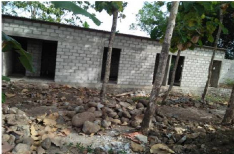
Gambar 41 Ruko yang masih dalam tahap pembangunan awal Sumber: diperoleh dari data dokumentasi pada tanggal 4 Juli 2018
