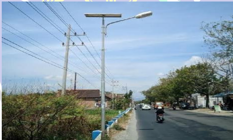
Gambar 2.1 Penerangan Jalan Umum (PJU)
