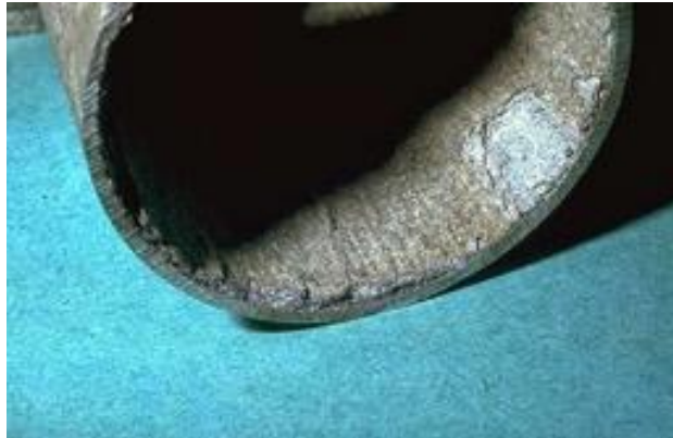
Gambar 2.8 Korosi Intergranular Pada Pipa ( Scribd.com/korosi )
