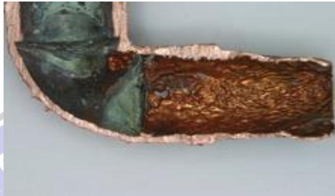
Gambar 2.12 Korosi Erosi Pada Pipa ( utomo, B.2012 )
