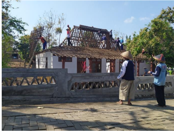
Gambar 3.9 Gotong Royong Renovasi Rumah
