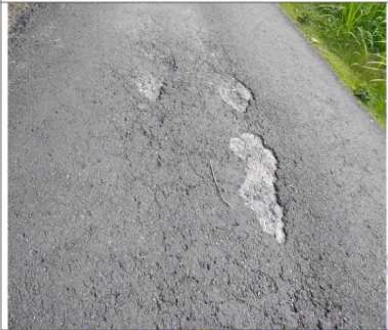
Gambar 5 Jalan Desa Golo
