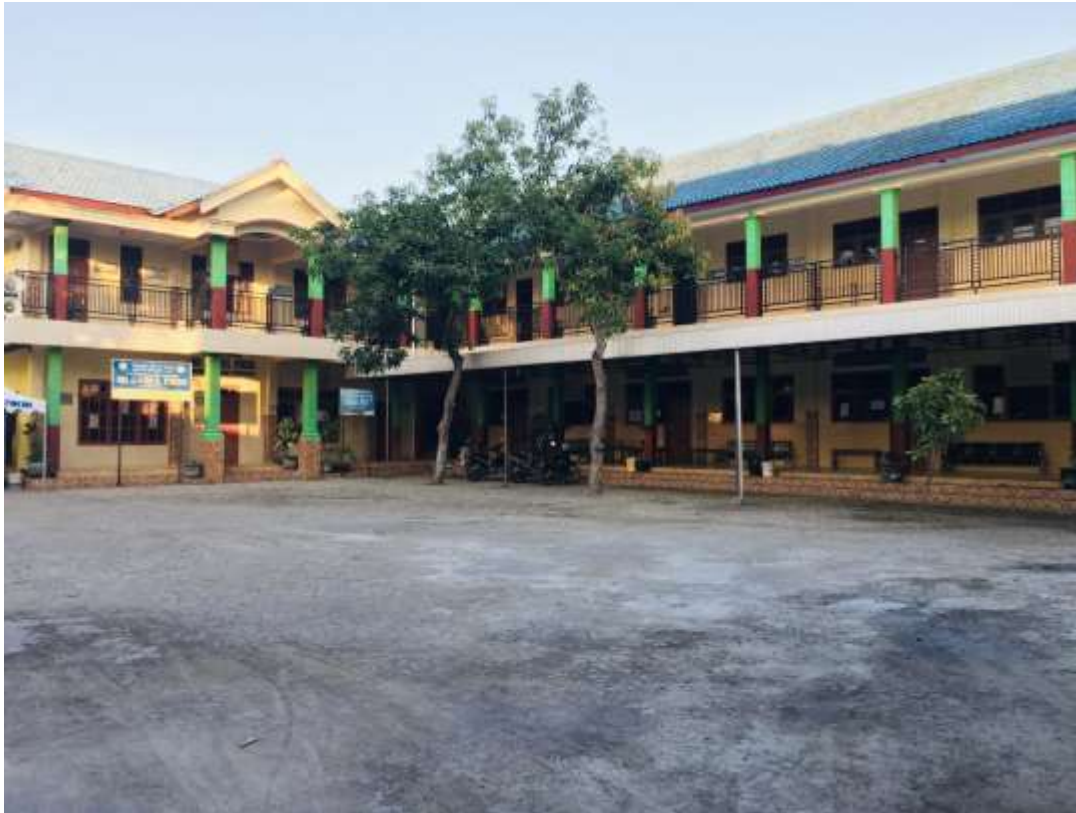
Gambar 3. Gedung Madrasah Ibtidaiyah Darul Fikri
