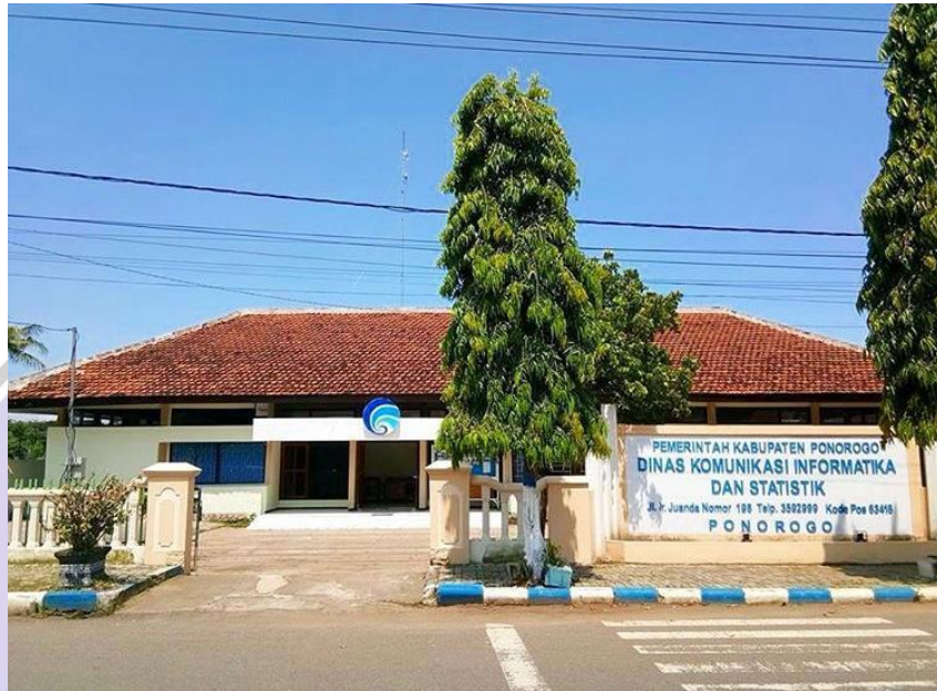
Tampak Luar Bangunan Kantor Dinas Kominfo dan Statistik Kabupaten Ponorogo
