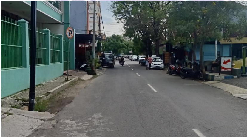
Gambar 8. Pemasangan arah rambu larangan parkir kurang tepat
