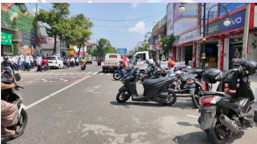
Gambar 9. Tidak ada marka jalan sebagai batas parkir
