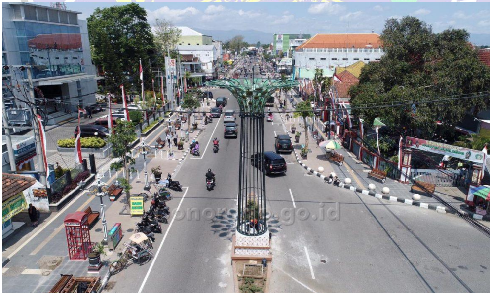
Kondisi Jalan Hos Cokroaminoto sebelum pembangunan face off (Sumber: ponorogo.go.id)
