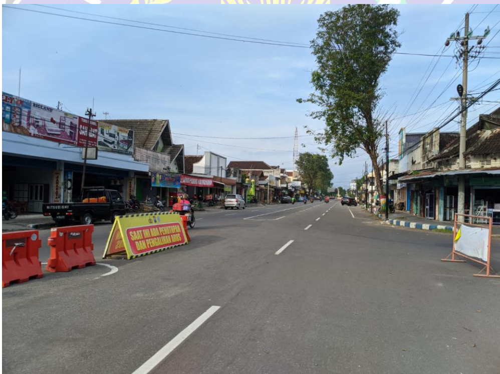
Kondisi Jalan Urip Sumoharjo sesudah pembangunan face off (Sumber: dokumen pribadi)
