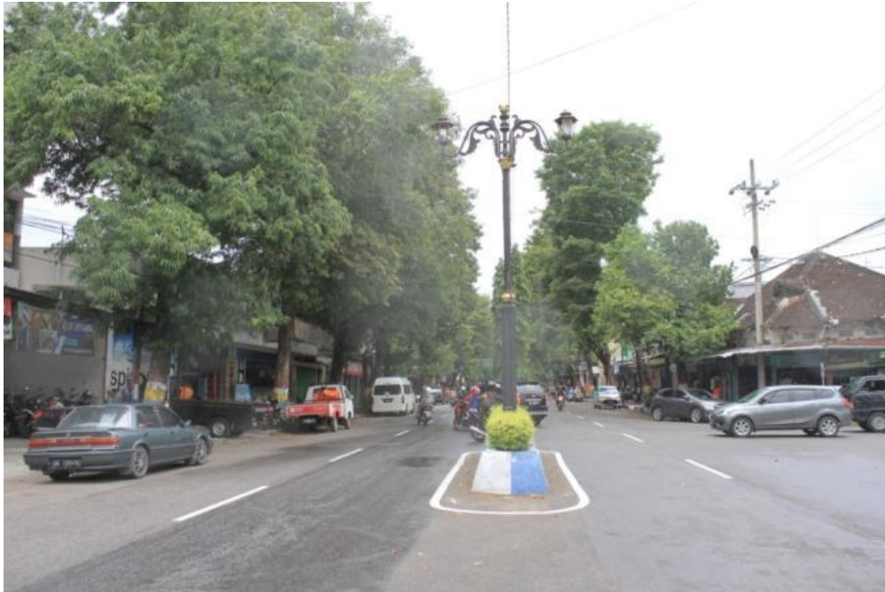
Kondisi Jalan Urip Sumoharjo sebelum pembangunan face off (Sumber: jawaposradarponorogo.com)
