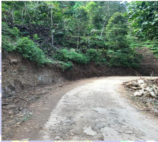
Gambar 1. 17 Akses Jalan Menuju Rt 15
