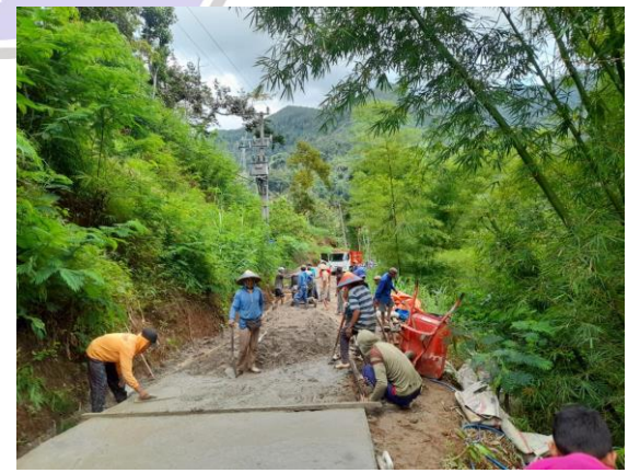
Gambar 6. Pembangunan Prasarana Jalan
