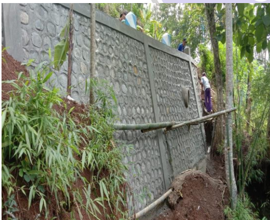
Gambar 5. Pembangunan Talud
