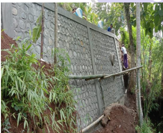
Gambar 5. Pembangunan Talud
