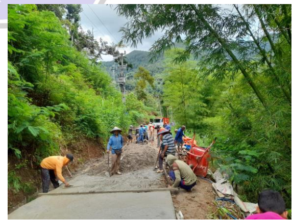
Gambar 6. Pembangunan Prasarana Jalan
