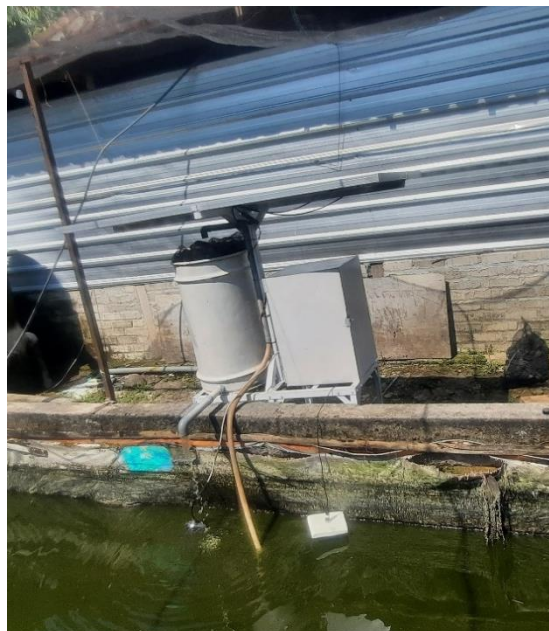
Gambar 4.1 Rangkaian sistem sirkulasi air kolam
