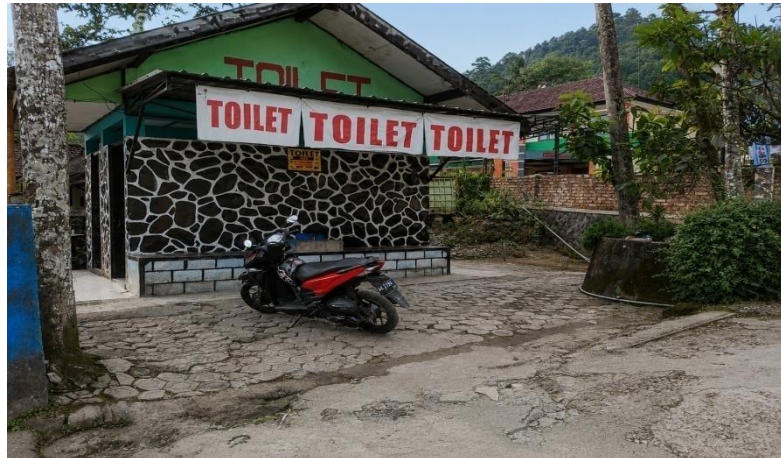
Gambar 5. Fasilitas toilet umum
