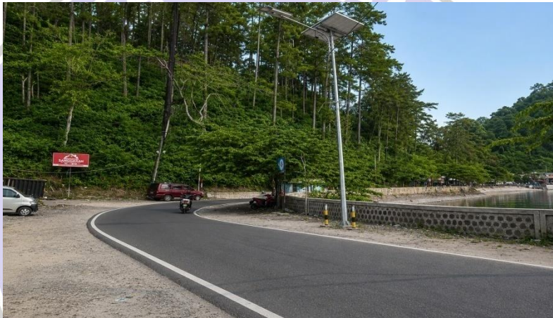
Gambar 2. Penerangan jalan di Telaga Ngebel
